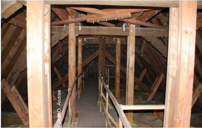
Neue Balken und Schrauben unterm Dach
